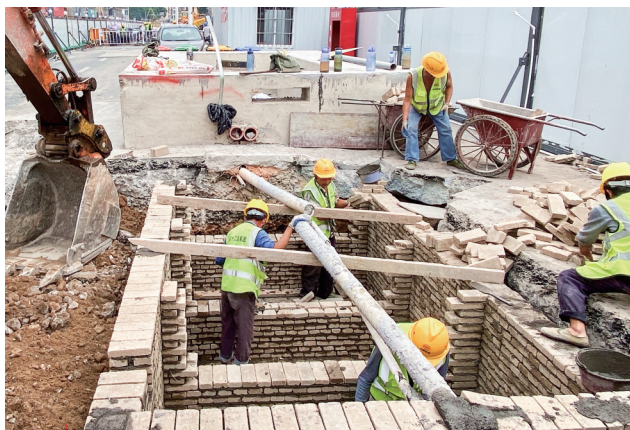
大同街道开足马力推进地铁6号线等重点项目建设。
