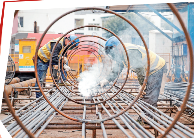
工人正在中医院康复楼施工现场紧张作业。记者 陈理杰 摄
