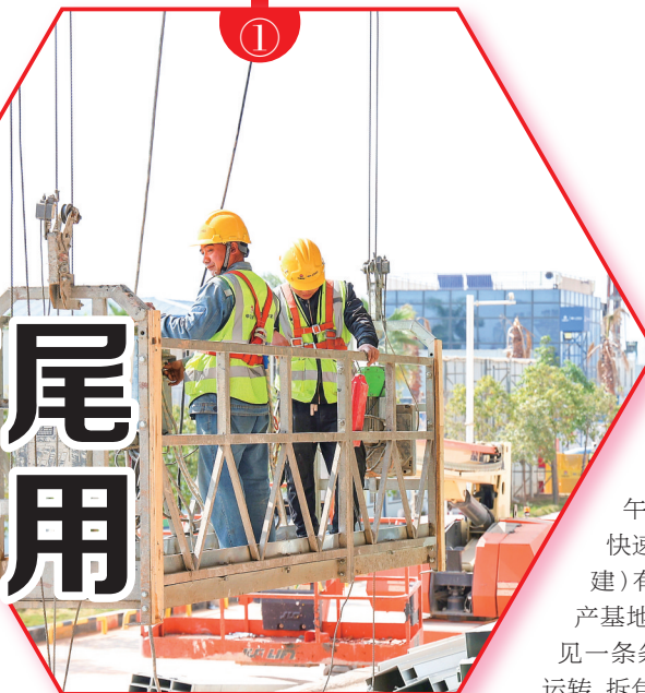
施工进入冲刺阶段。叶嘉健 摄
