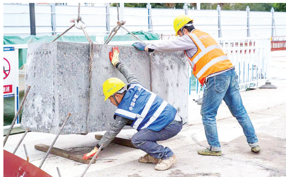
厦门电力与清水进岛隧道项目建设现场,工人正在施工。
