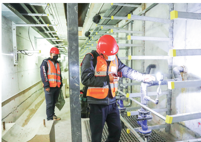
工人逐段巡查、检修,有序推进项目收尾工作。记者 唐光峰 摄
