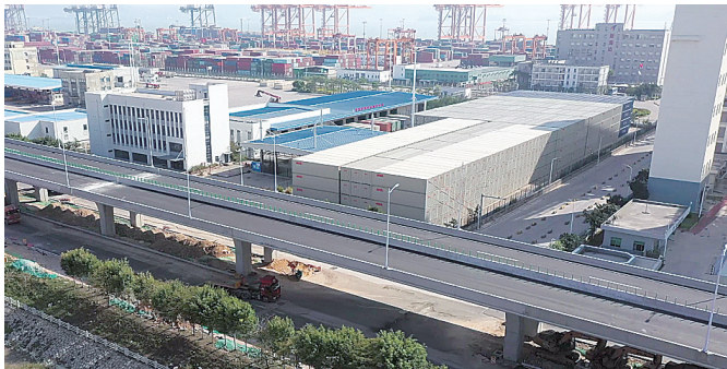
海沧沧江路快速通道工程立交桥部分已全部完工。
