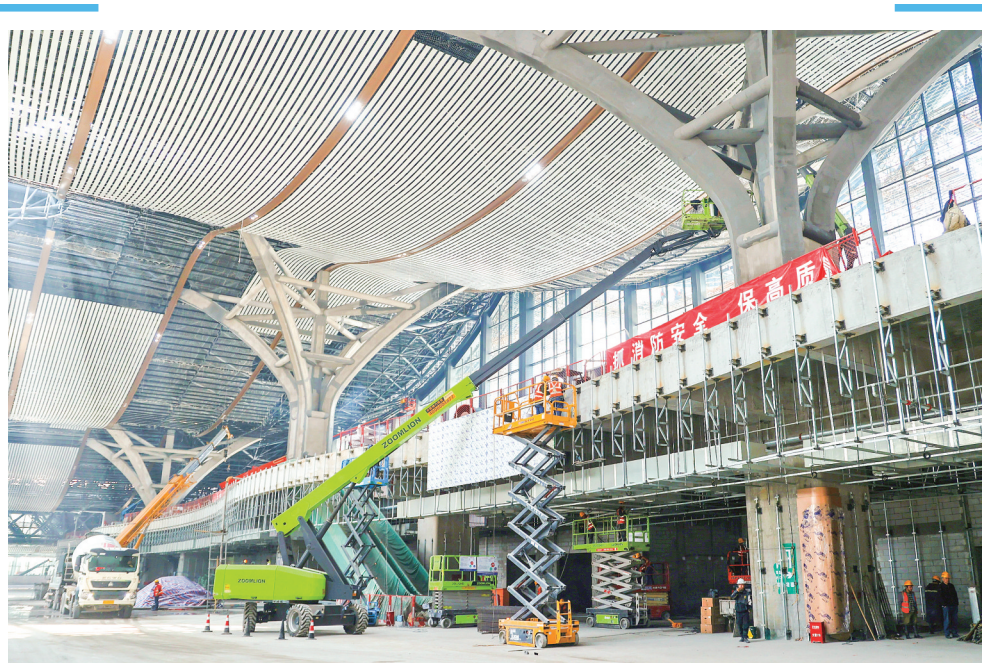
新建厦门北站全面进入装饰装修和机电安装施工阶段。记者 叶嘉健 摄
