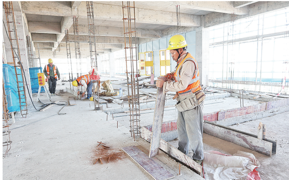
工人正在加紧进行施工。记者 陈理杰 摄
