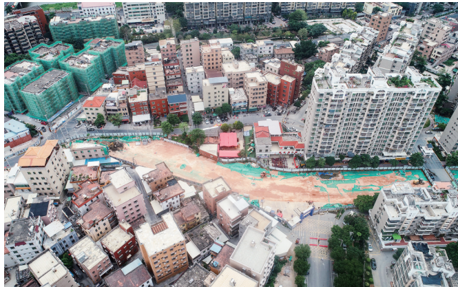
城北六号路南段(古庄新城—环城北路段)项目已完成70%的工程量。
