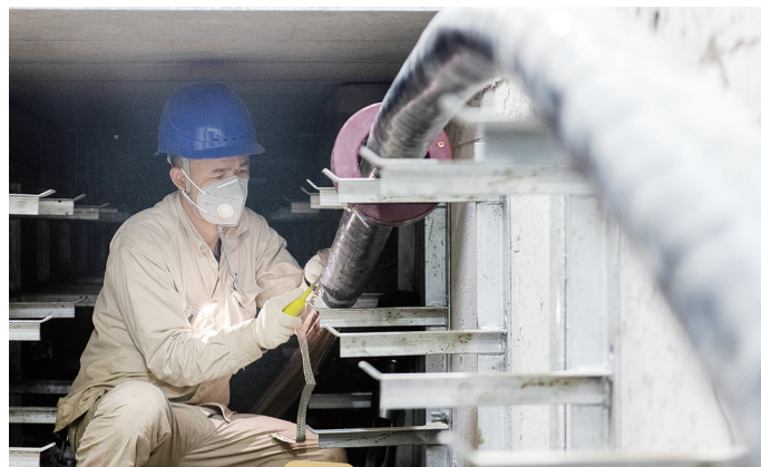
在110千伏桂园变电站,厦门市供电服务有限公司施工人员于狭窄的作业空间内制作电缆头。许烨玮 摄
