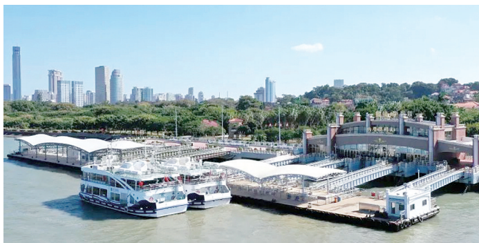
鼓浪屿内厝澳码头扩建工程顺利通过竣工验收。
