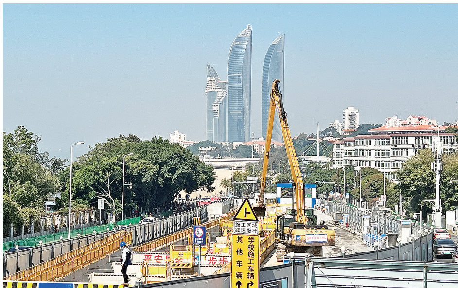
昨日上午,地铁3号线南延段厦大白城段进入土方开挖阶段。 记者 柯小娇 摄
