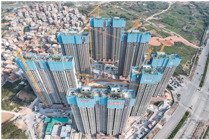
新浦嘉园安置房项目B1标段航拍图。
