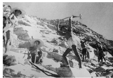
海堤建设者开山劈石,用铁轨运石。本组图片来自《移山填海话当年——厦门海堤建设回顾》
