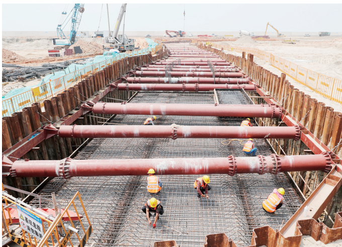
项目建设现场,工人正抓紧施工。记者 陈理杰 摄
