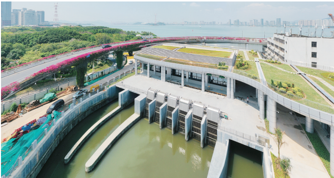
筼筮湖第二排涝泵站。厦门市政园林局供图
