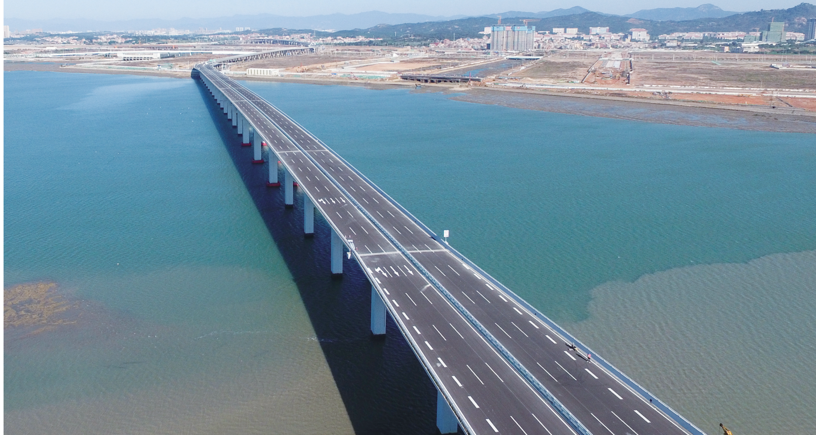
溪东路上的溪东大桥是福建省首座双层跨海大桥，也于昨日通车。 (厦门市政集团开发公司供图)
