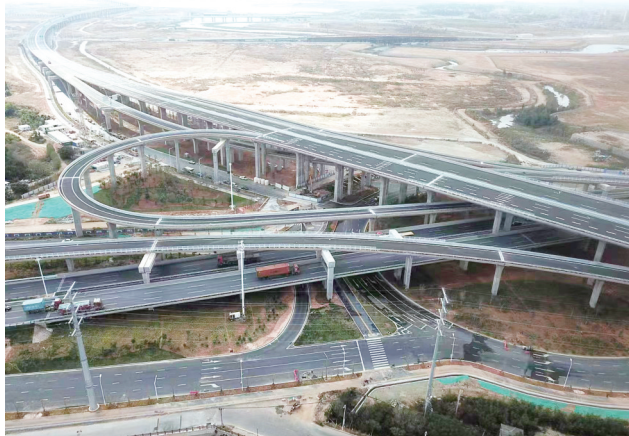
溪东路起于与翔安南路交叉的茂林互通。厦门市政集团开发公司供图
