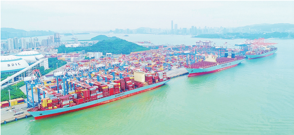
三艘15万吨级以上超大型集装箱船舶同时靠泊厦门港。
