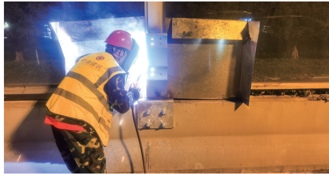
施工人员在仙岳高架护栏进行改造。
