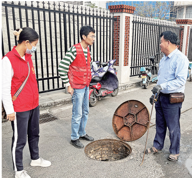
林荣昆(左二)实地查看名仕阁小区下水道堵塞问题。
