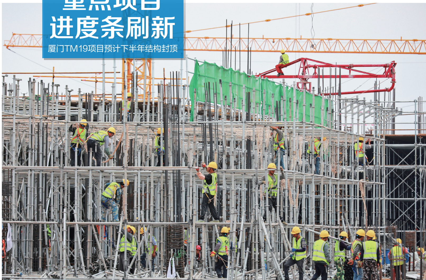
厦门天马光电子第8.6代新型显示面板生产线项目进入主体结构施工及移交的冲刺阶段。
