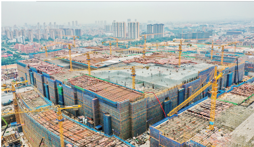
厦门天马光电子第8.6代新型显示面板生产线项目各项节点目标超时序完成。通讯员供图
