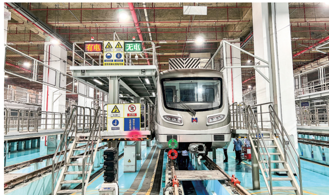
检修人员对地铁列车空调进行“洗吹检”。记者 柯小娇 摄
