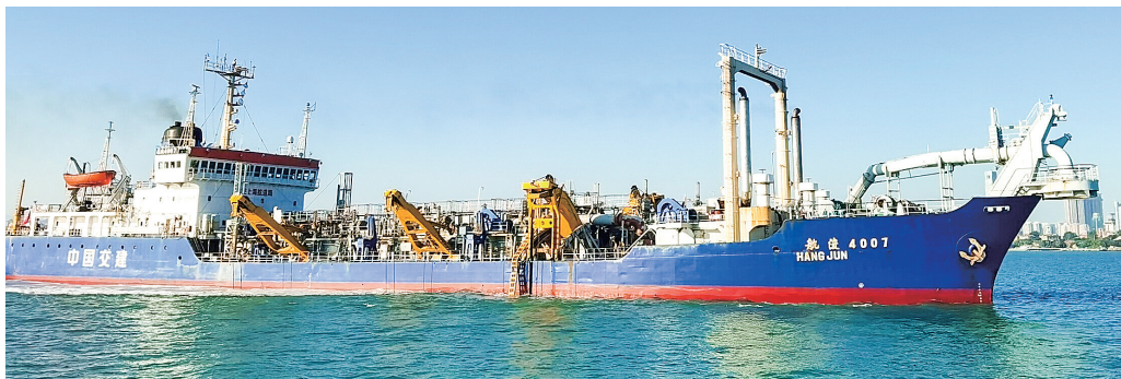
厦门港3号锚地疏浚作业。
