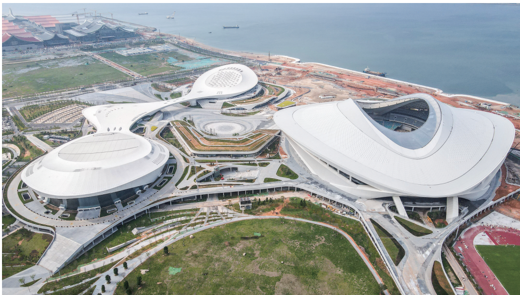
白鹭体育场(右)施工进入收尾阶段。中建四局供图
