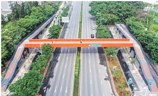
翔安火炬实验学校人行天桥正式启用。
