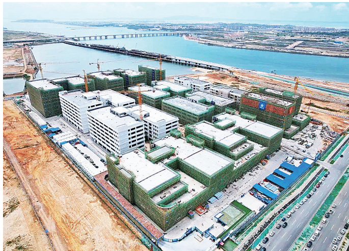
厦门航空产业园项目近日顺利完成主体结构封顶。
