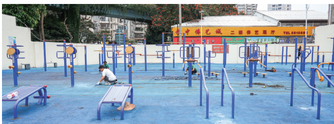
岛内“最老体育场”改造施工接近尾声。记者 王世伟 摄
