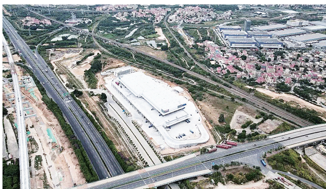
德邦物流园福建总部暨厦门智慧物流产业园项目投产运营。
