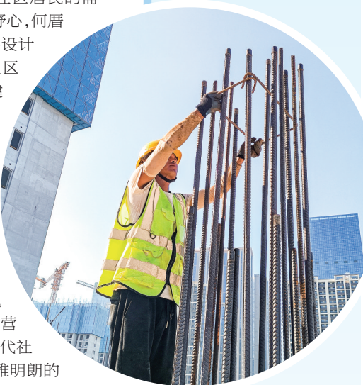
施工人员进行墙柱钢筋安装绑扎。何厝岭兜片区分指挥部供图
