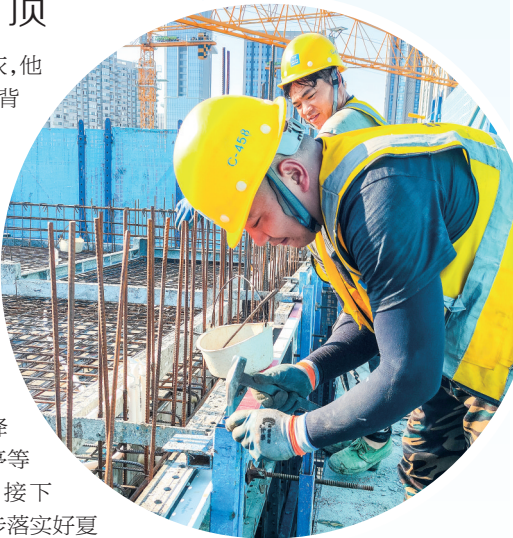
模板工人正在进行铝模安装。何厝岭兜片区分指挥部供图
