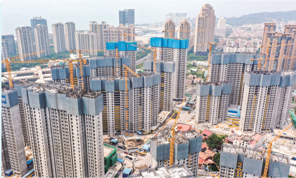
岭兜安商房施工现场。
