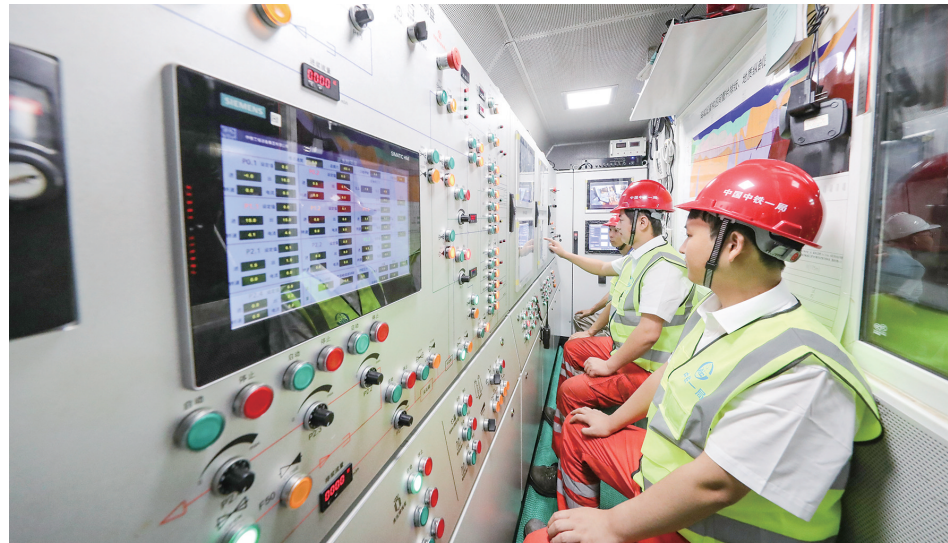
厦门电力与清水进岛隧道土建工程海域段盾构顺利始发。 记者唐光峰摄
