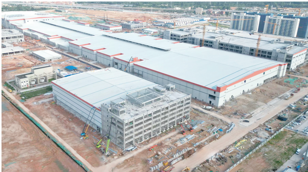
厦门时代新能源电池产业基地项目(一期)主体结构已全面封顶。
