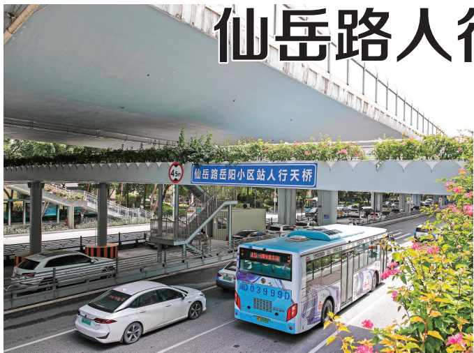
仙岳路岳阳小区站人行天桥。记者 陈理杰 摄
