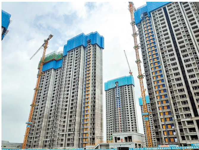
陈井浦边潮瑶安置房项目建设顺利推进。
