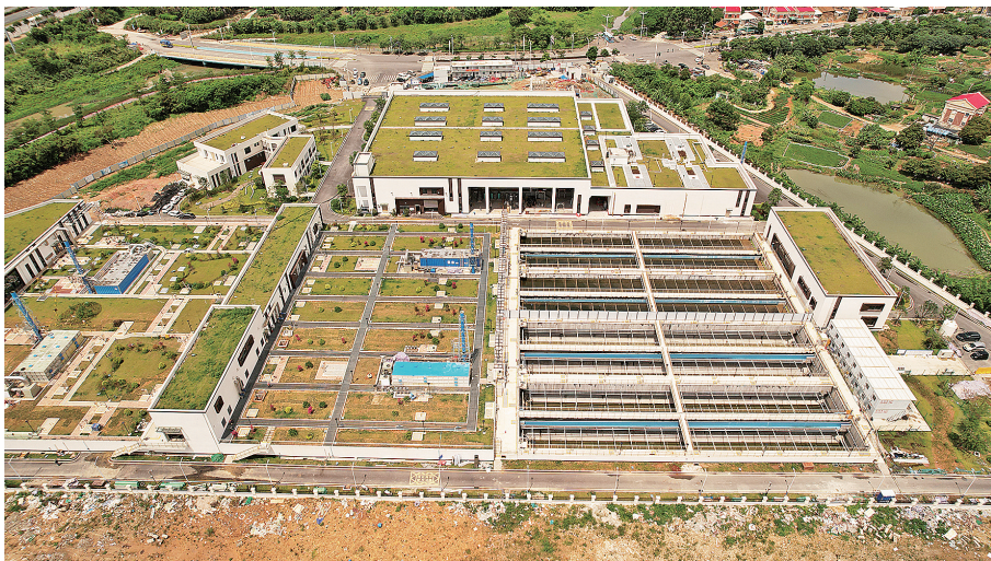
前场水质净化厂二期工程按计划施工中。
