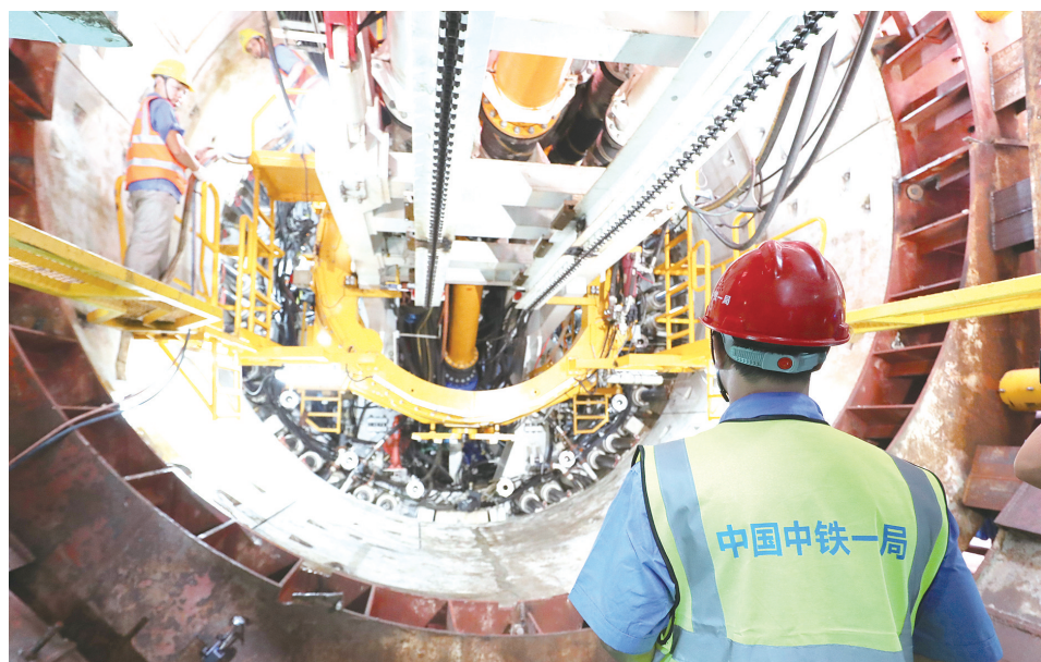
6月19日,厦门电力与清水进岛隧道土建工程海域段盾构顺利始发。 记者唐光峰摄
