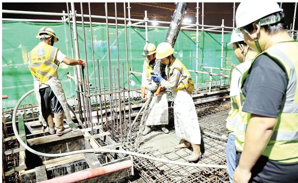
湖滨中学实验综合楼建设现场。
