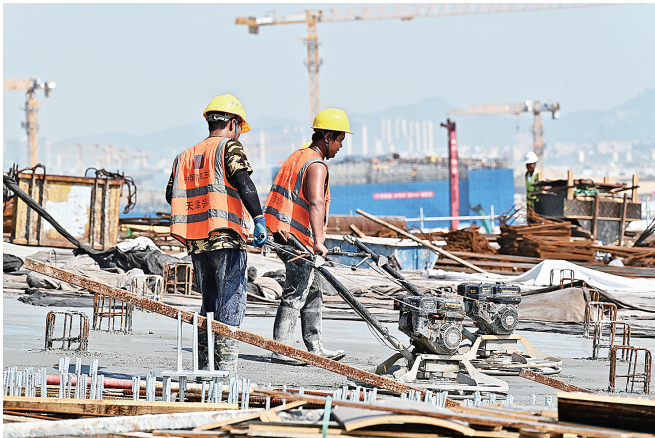
翔安机场C指廊主体结构混凝土浇筑施工现场。林茂森 摄
