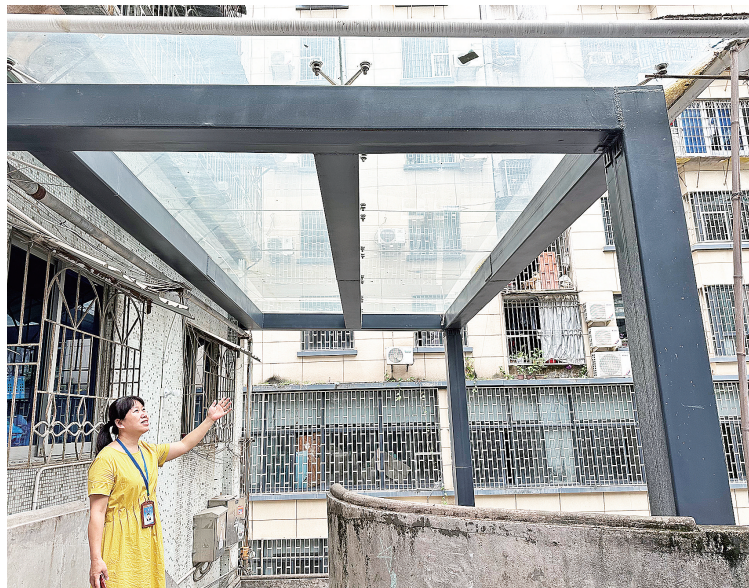
城西社区党委书记、居委会主任陈丽彬介绍金安楼小区楼梯雨棚建设情况。
