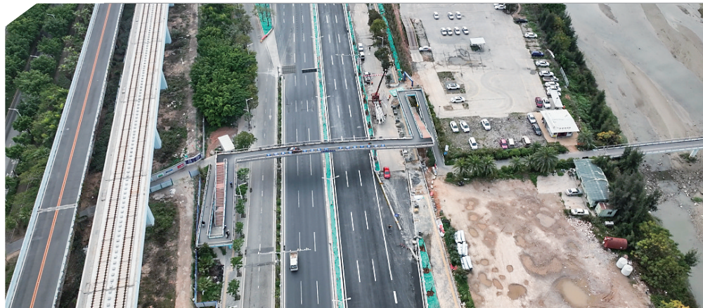
海翔大道(官浔立交-西柯立交)竣工通车后,进一步提升车辆通行效率。
