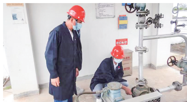
工作人员正在检测燃气管道。
