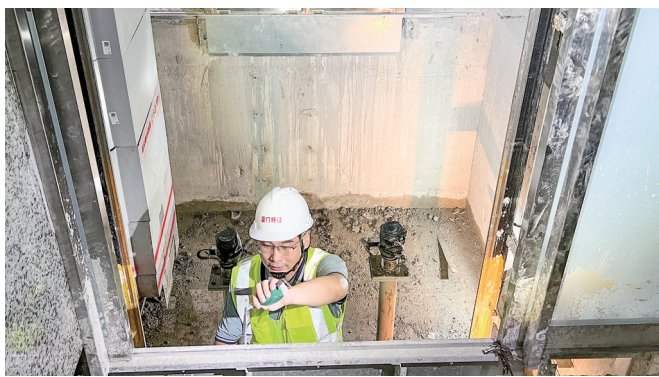
福厦高铁厦门北站电梯接受“体检”。
