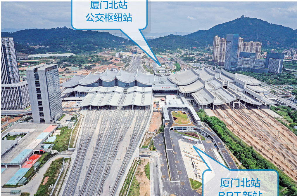
全新厦门北站。记者 陈理杰 摄
