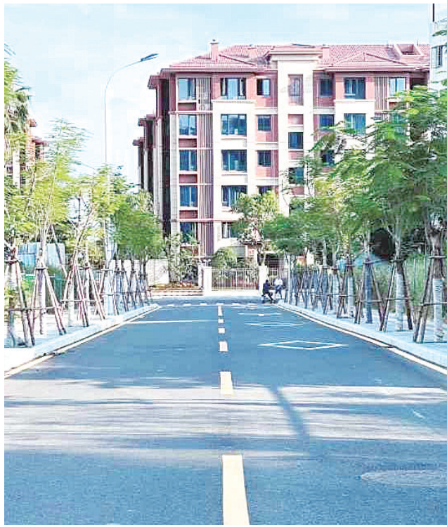
黄厝会议中心安置房周边配套道路日前正式通车。思明区市政中心供图
