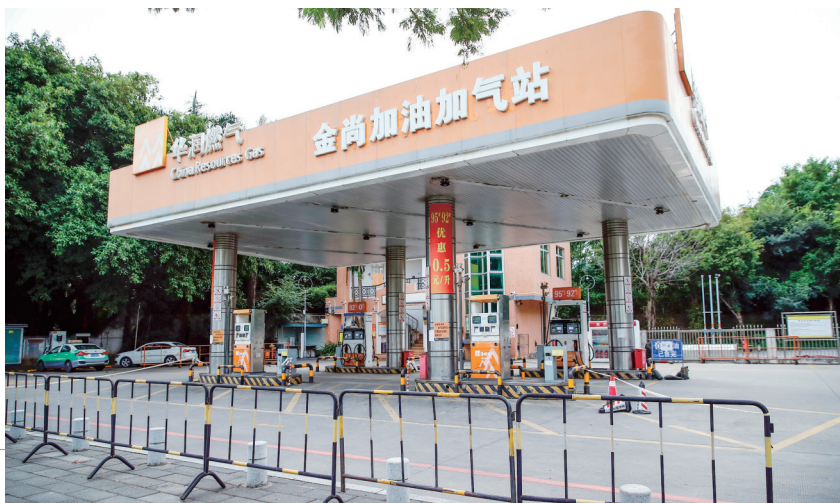
华润燃气金尚路加油加气站已暂停运营。 记者 陈理杰 摄
