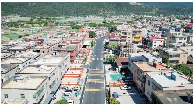
新圩两条县道完成改造提升。
