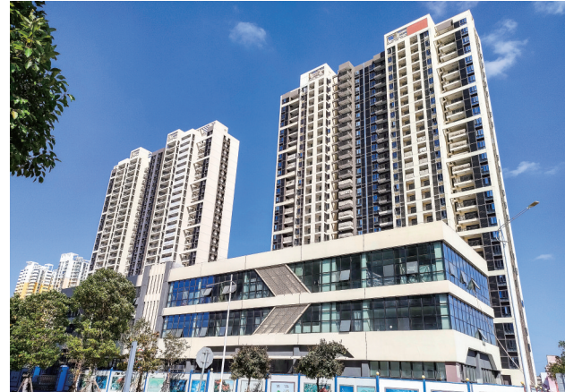
五通金浦花园安置房项目已竣工并完成验收。
