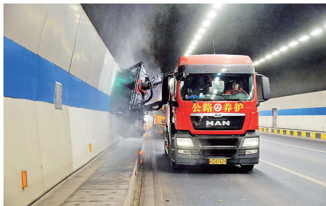
深夜时分,隧道清洗车清洗隧道壁。
