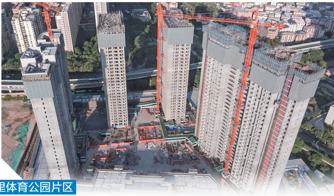
西潘安置型商品房项目已封顶。
