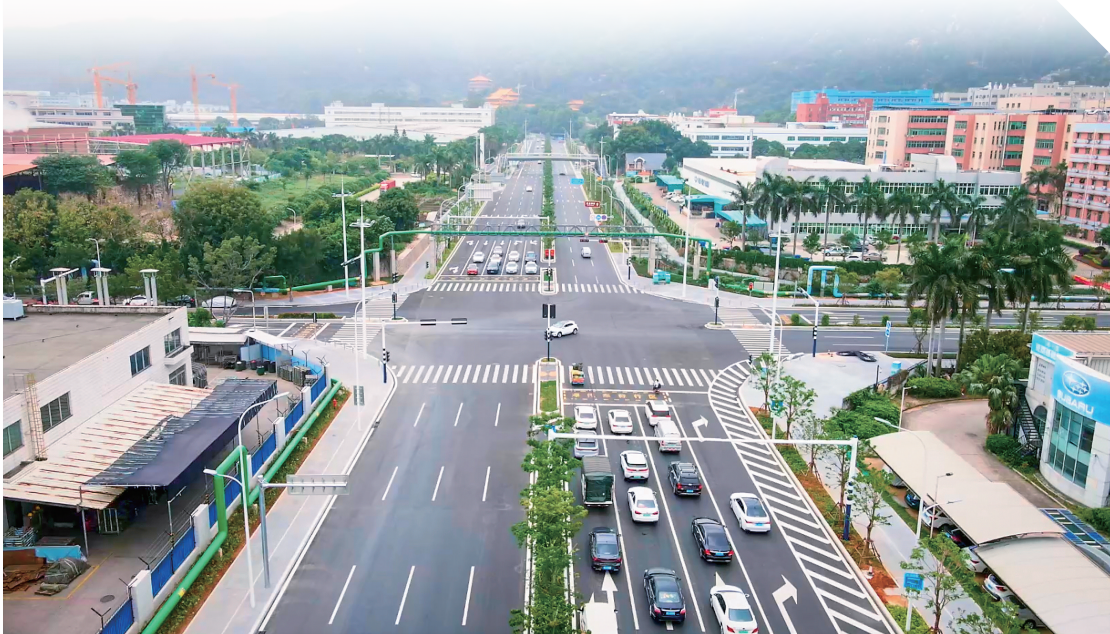
霞飞路提升改造工程A标段全长1.32km,是城市主干道。
