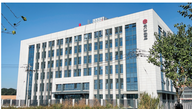
综合管廊运营管理用房已建设完工。记者 仇慧亮 摄
