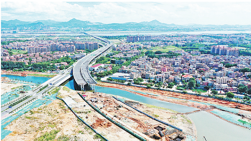
翔安机场快速路大嶝岛段B2标正在加紧施工。
