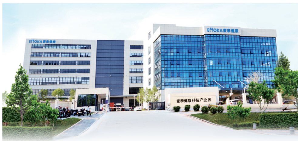
厦门蒙泰健康科技产业园正式投产。
